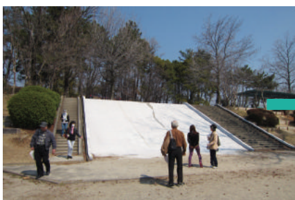
藤白台ふじのき公園 改修前
