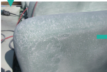
手すり部分の仕上げ研ぎ
