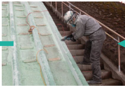
手すり部分の荒砥ぎ
