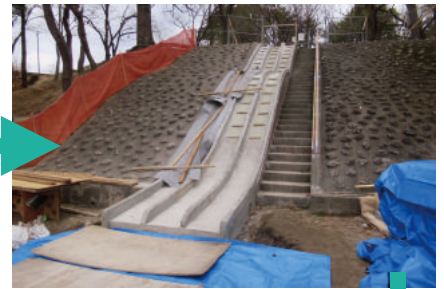
改修工事開始
